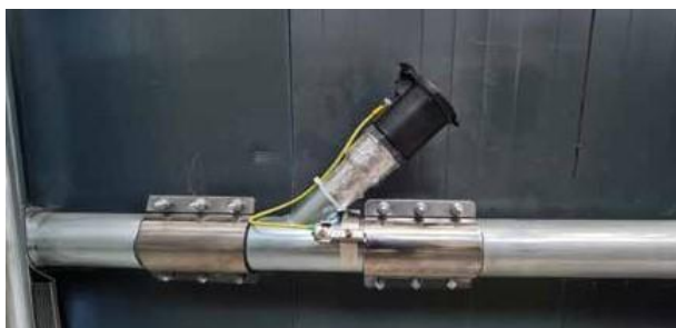
Presa Antistatica collegata con cavo di messa a terra.
