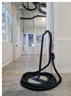
Presa Antistatica collegata con cavo di messa a terra.
